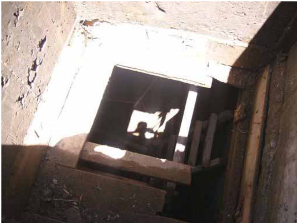
The cistern interior.
